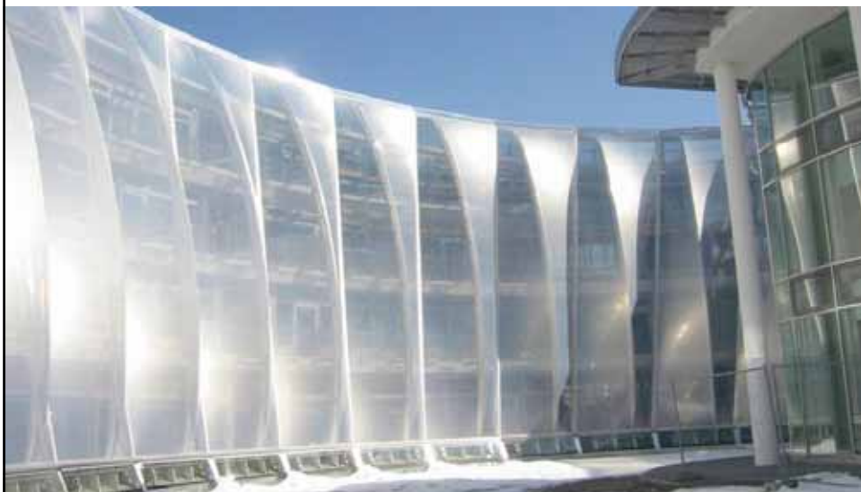
Zentrum für Gerontologie, Bad Tölz, Germany
