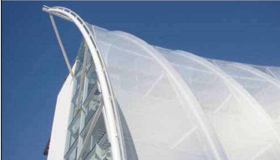
Zentrum für Gerontologie, Bad Tölz, Germany
