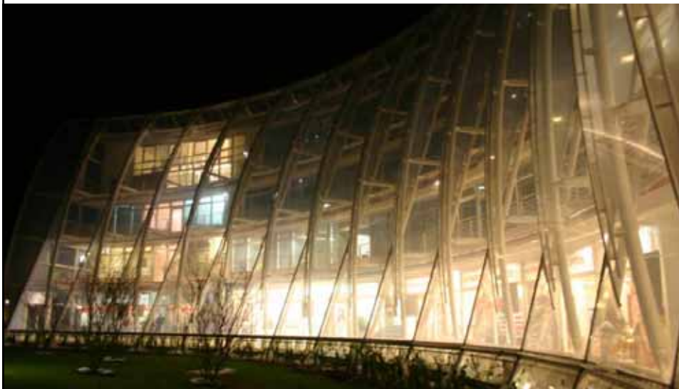
Zentrum für Gerontologie, Bad Tölz, Germany
